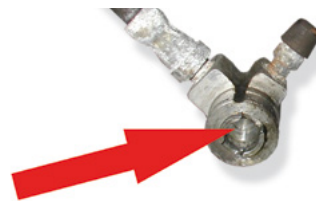
3. ábra: Csatlakozódido ellenőrzése
